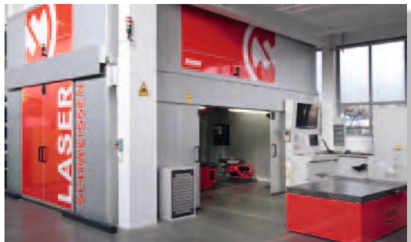
Die Laserschweißzelle mit je einem extra breiten und einem extra hohen Tor wird über Schiebetische auf Schienen bestückt. Alle Wände sind mit Laser-Spy-Sensoren gegen Durchschuss gesichert.
