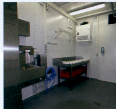
Sobald das Modul an den gewünschten Standort transportiert und an Wasser, Abwasser und Strom angeschlossen wurde, ist es einsatzbereit
